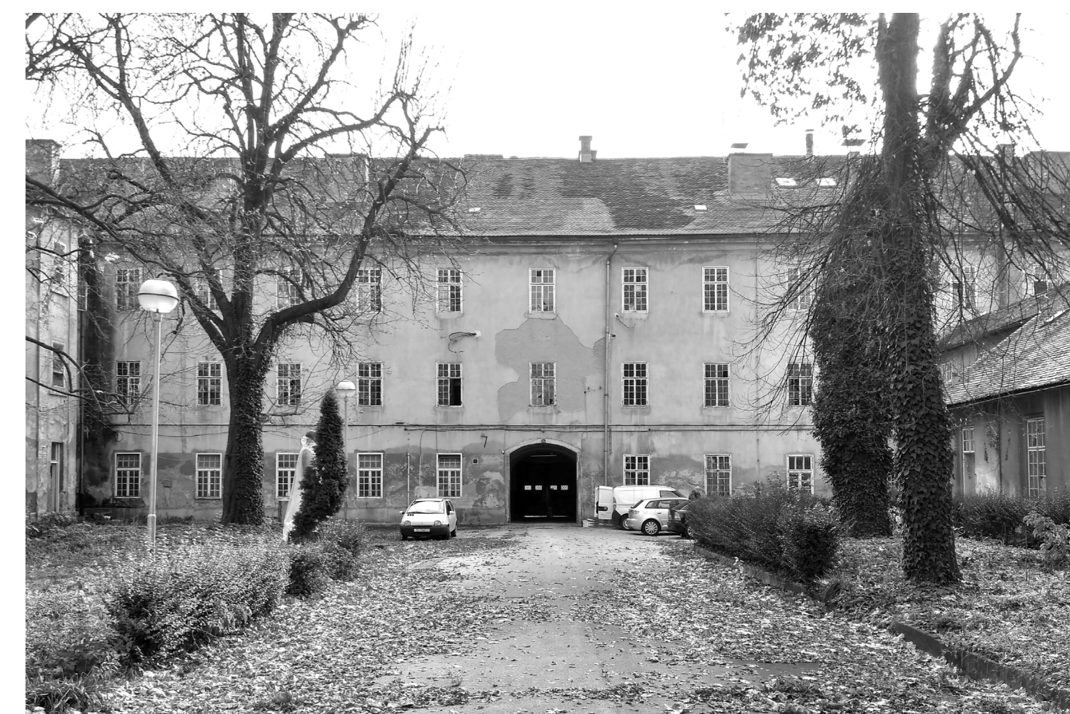
Ulična zgrada s dvorišne strane
